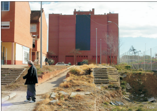
Zona a restaurar en el entorno de las antiguas 48 Viviendas.
