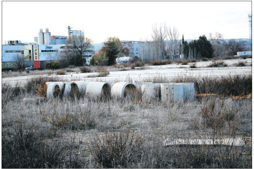
Tubos de fibrocemento con amianto en la parcela de Ibertubo.
