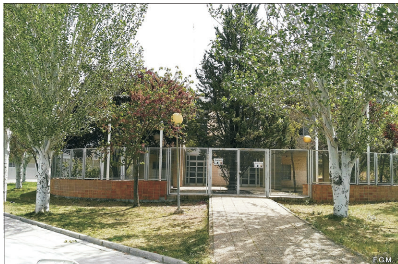
La Casa de la Cultura necesita tener regulada su apertura y conserjería.
