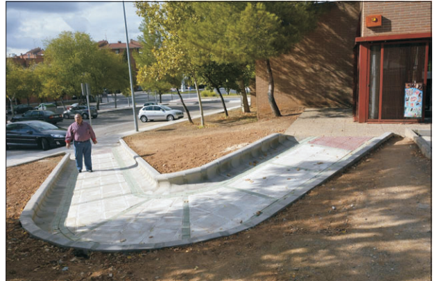
Una rampa que era necesaria.
