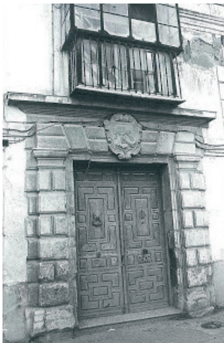
Ilustración 17. Fachada de la casa familiar, ya desaparecida, de los Ibarrola. Estaba situada en Ciudad Real, en la calle Toledo frente al palacio de la Diputación Provincial.
