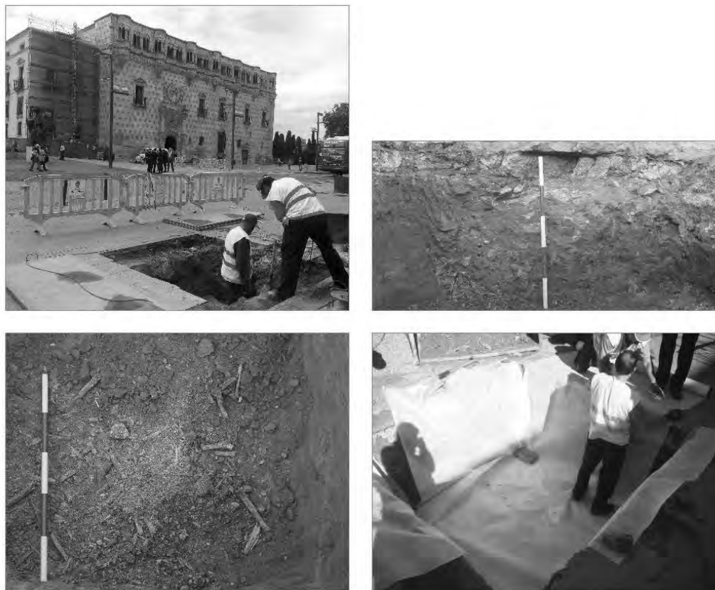
Figura 8. Proceso de trabajo y protección de la estructura en Plaza de España.
