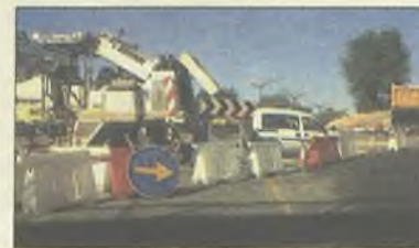
Imagen de las obras de la rotonda
