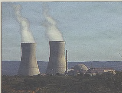
La central nuclear de Trillo
