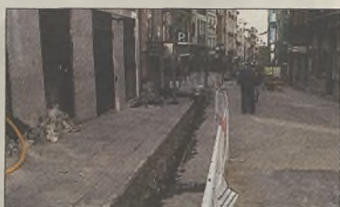
Obras en el centro de la ciudad
