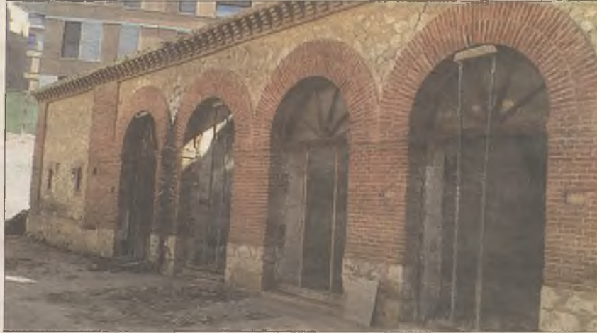
Aspecto actual del antiguo Matadero municipal de Guadalajara
