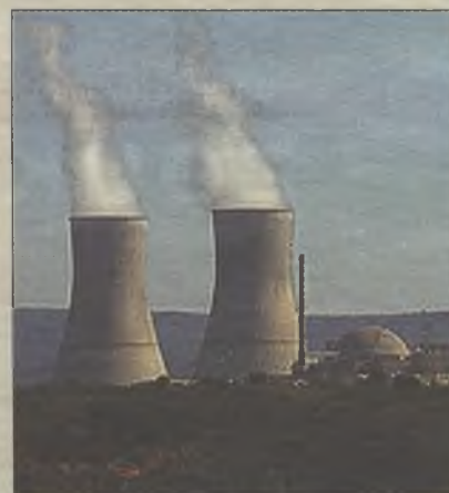
Imagen de la Central de Trillo
