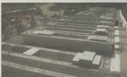
Imagen de las obras
