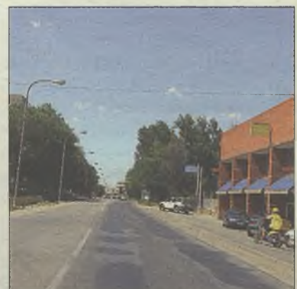
Un tramo de la vía Francisco Aritio
