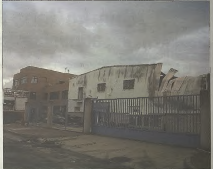
Imagen de una de las naves del Polígono Aida de Azuqueca de Henares
