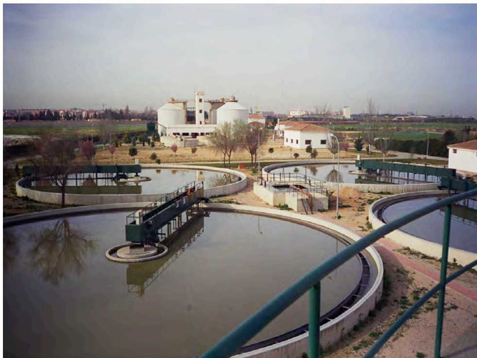
Figura 0. Vista panorámica de la Estación Depuradora de Aguas Residuales de Albacete.
