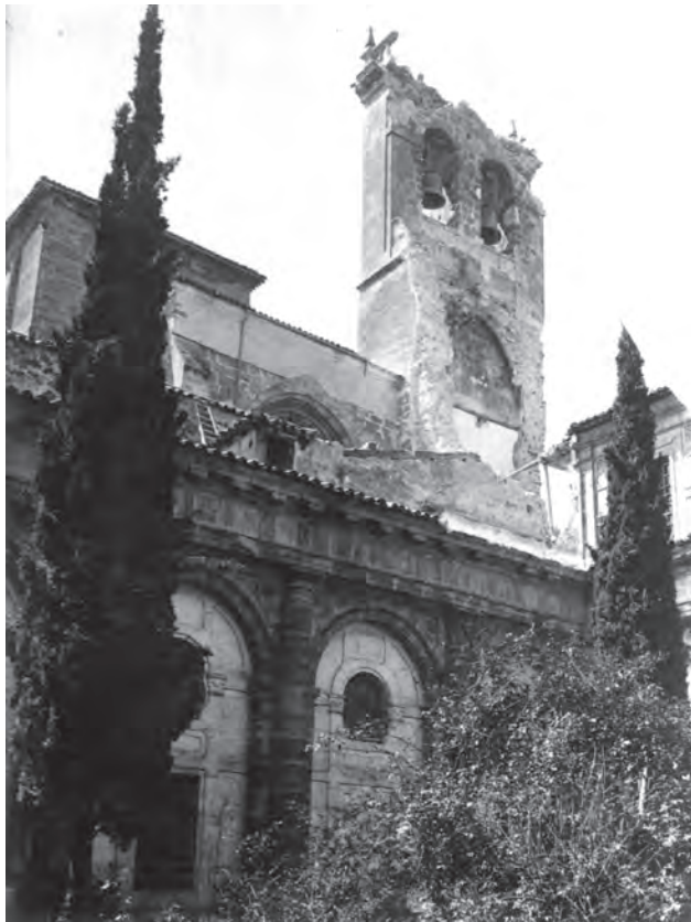
Claustro de la catedral de Cuenca y ruinas de la torre del Giraldo
