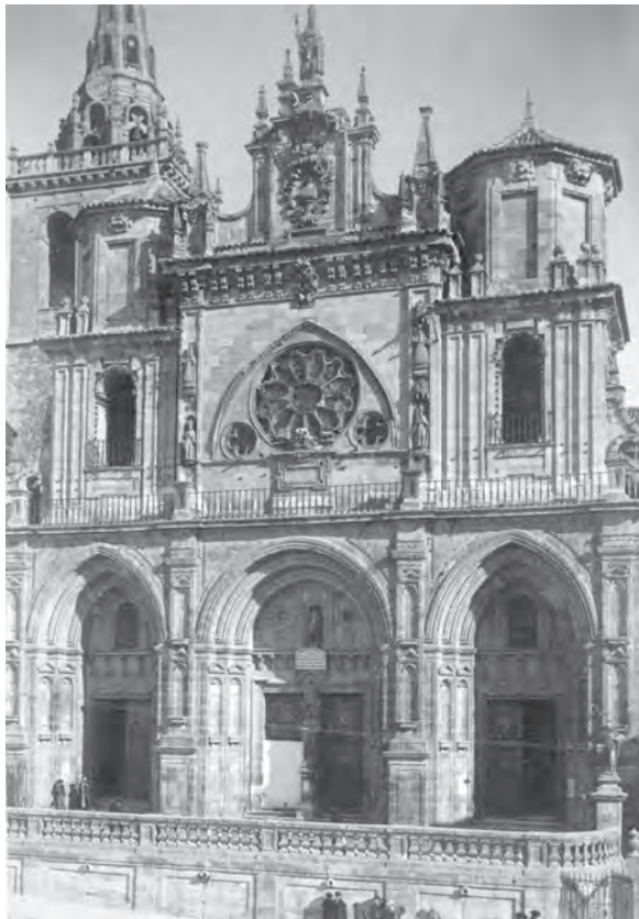
Fachada destruida de la catedral de Cuenca
