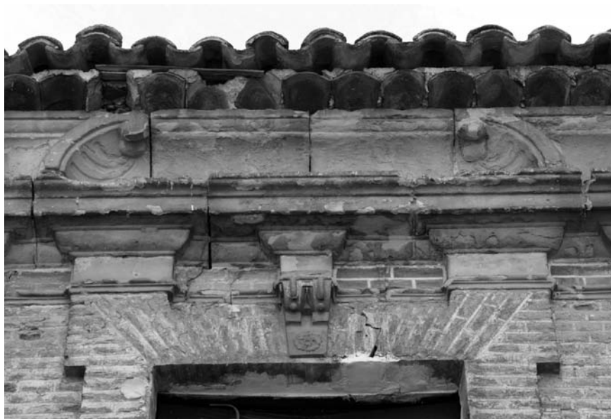
Detalle del claustro. Frontón.
