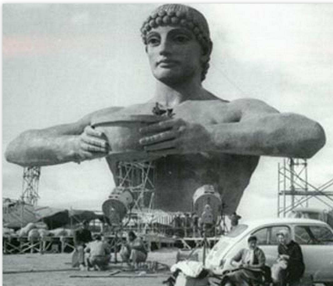
Montaje del “Coloso de Rodas”, en el Puerto de Laredo (Cantabria)
