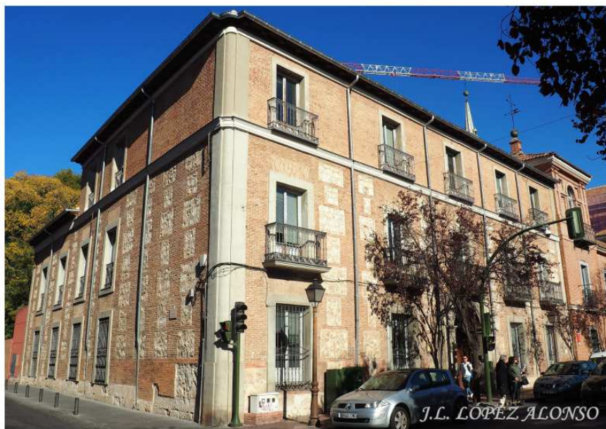
ALCALÁ DE HENARES: COLEGIO SANTA MARÍA DE LA REGLA
