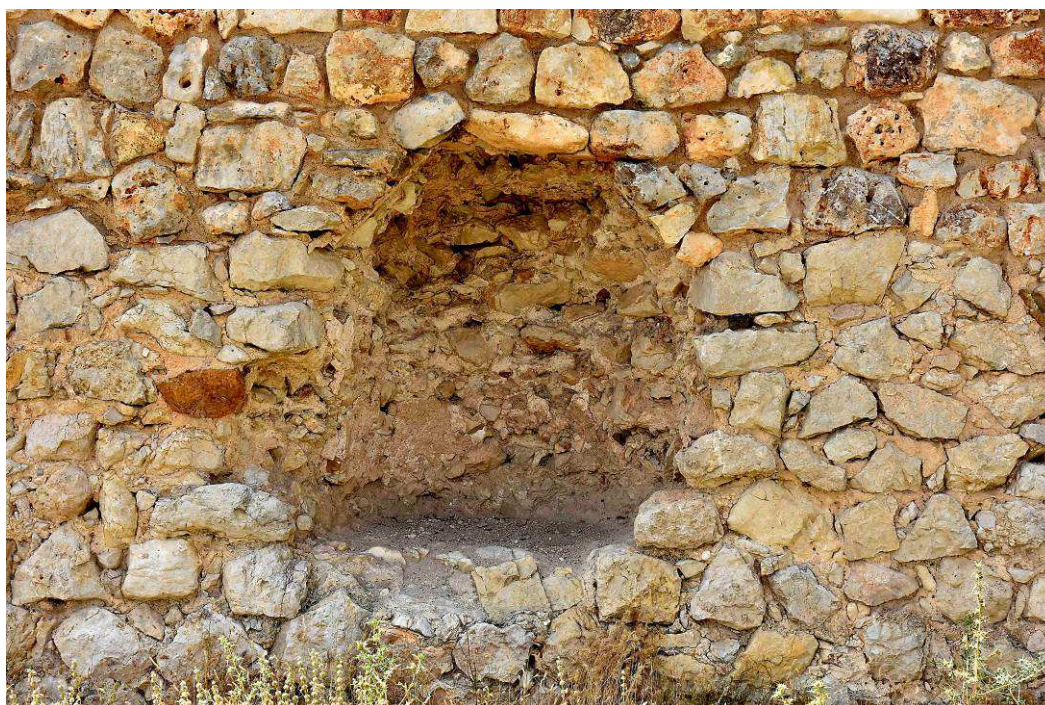
Intento de segundo agujero en la muralla
