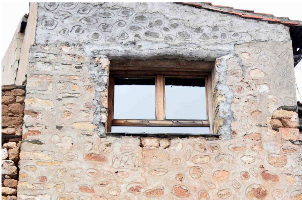
Óvalos que dejan ver en su parte central los mampuestos del interior
