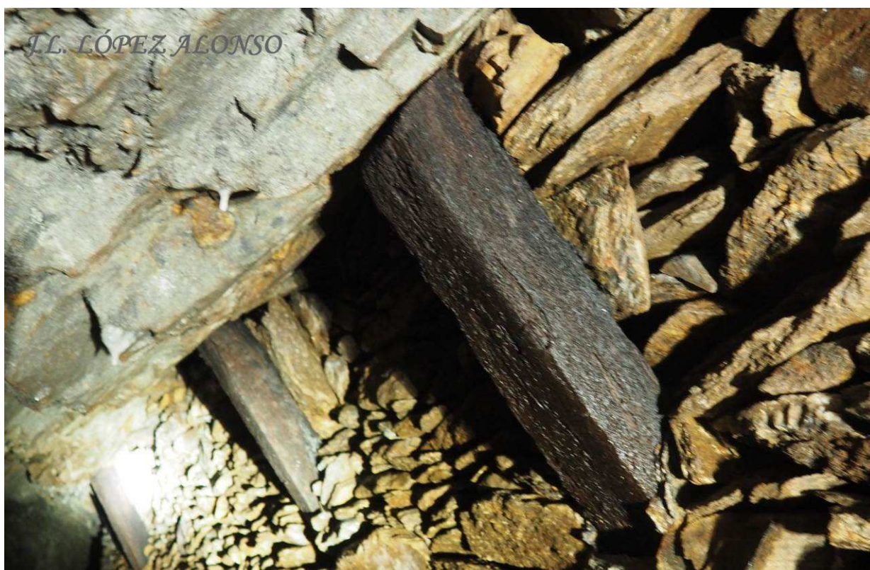
PUNTALES QUE PROTEJEN LA GALERÍA DE LA MINA
