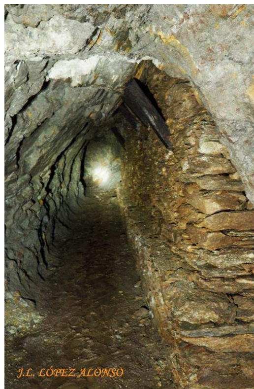
MURO Y PUNTALES QUE PROTEJEN LA GALERÍA DE LA MINA
