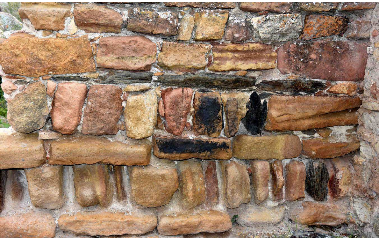
Aspecto del cerramiento con sillarejo a soga y tizón.
