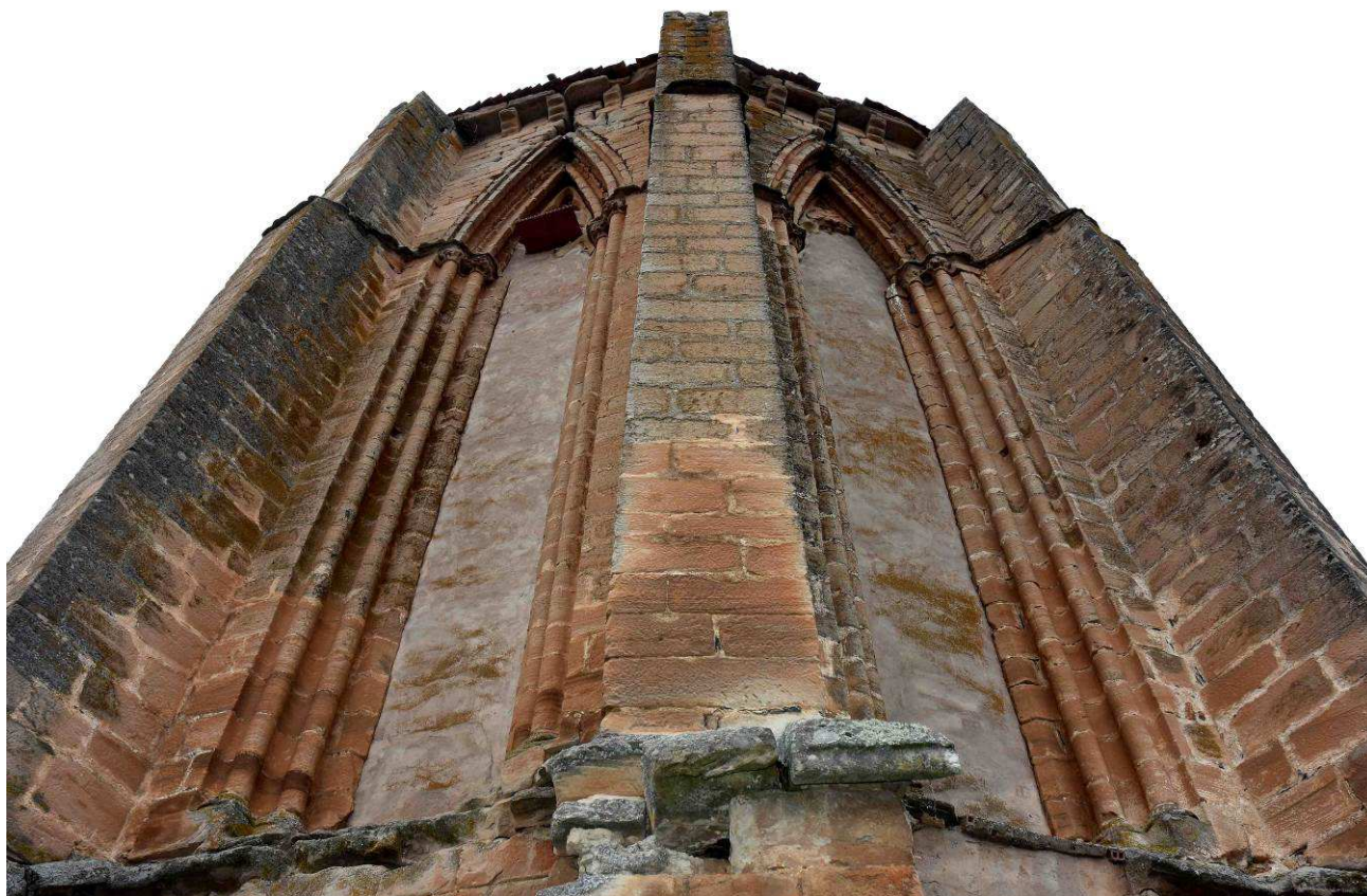
Detalle de dos de los largos y estrechos ventanales con arco en ojiva muy cerrada
