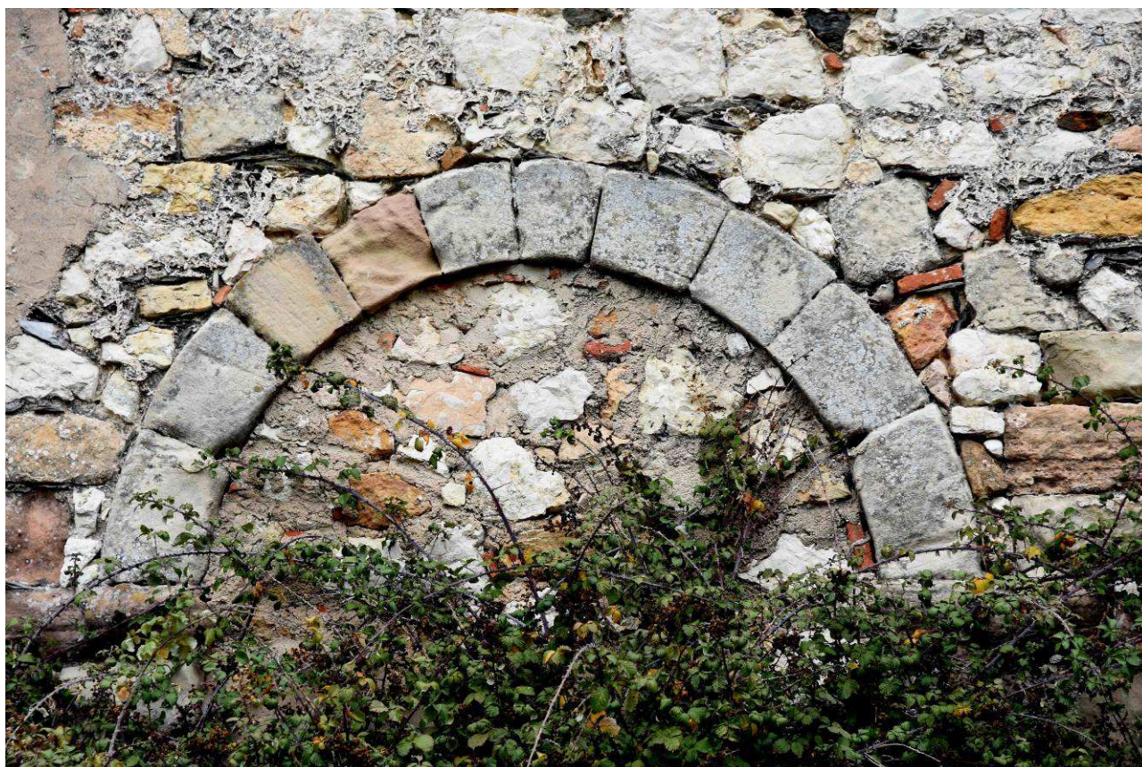
Arco de sillar cegado, sobre los mampuestos del cerramiento amurallado de la cara sur
