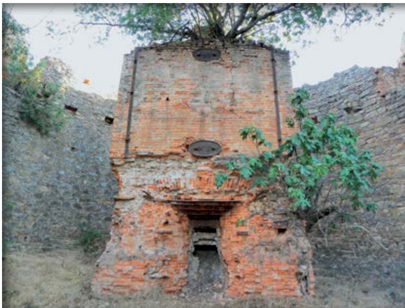
▣ 6 Restos del horno de fundición de hierro del Martinete, Los Pozuelos de Calatrava.
