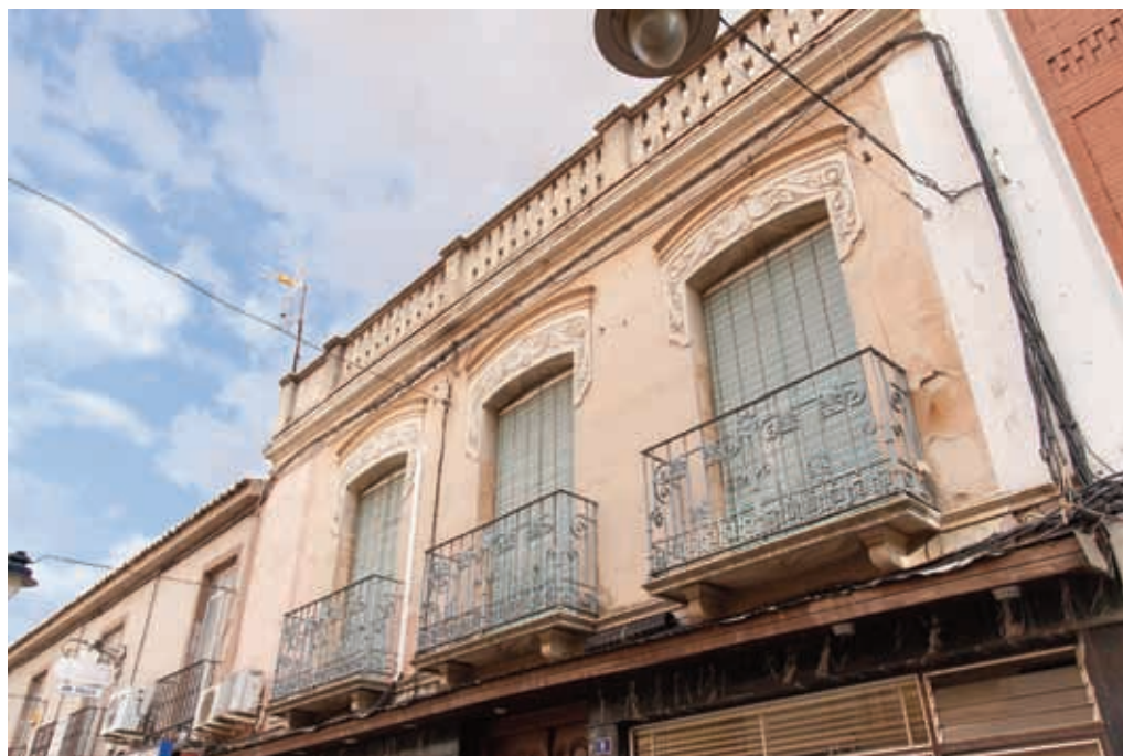
Fig. 2. Casa en calle Fontecha, 11
