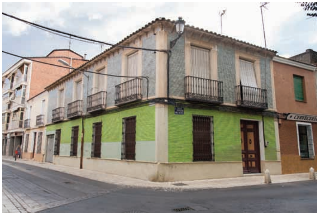
Fig. 3. Casa en calle Gregorio Molinero, 1
