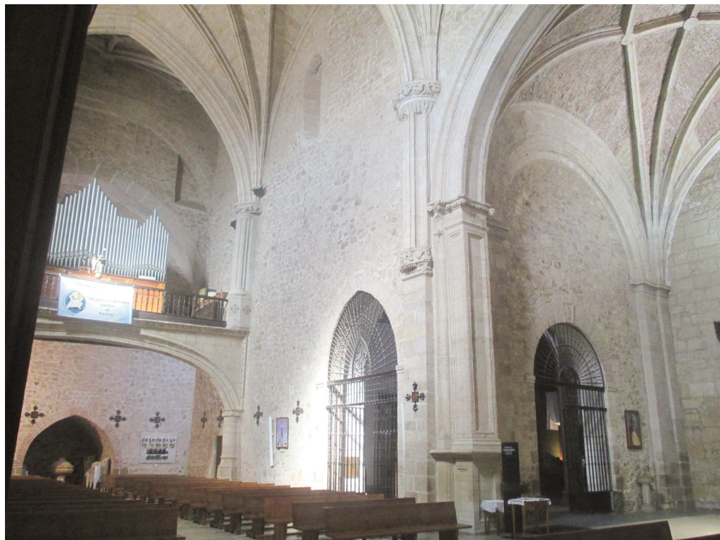
Fig. 1: Capilla penitencial, situada en la nave de San Lorenzo. Iglesia de La Asunción, Valdepeñas. Foto autor.
