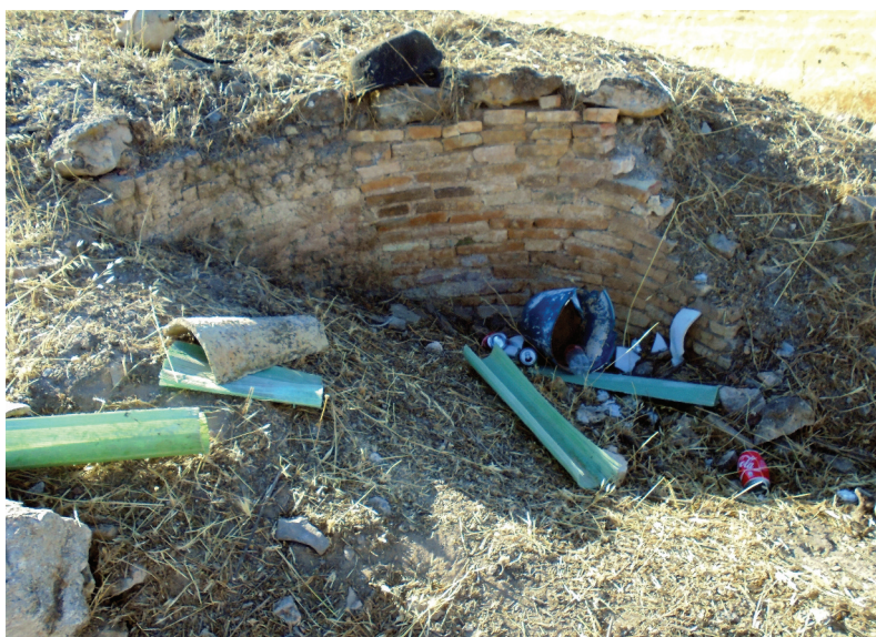
Imagen I. Vista de calera con basuras y residuos.
