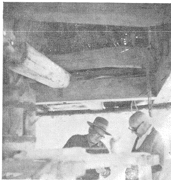
Tiburcio al lado del empiedro, explica el funcionamiento de la guitarra. Sobre las cabezas es muy ostensible el armazón del telar. El palo curvo y blanquecino que lo cruza a la izquierda es el puente, en cuyo centro entra el barrón de la linterna que se ve debajo de él.
