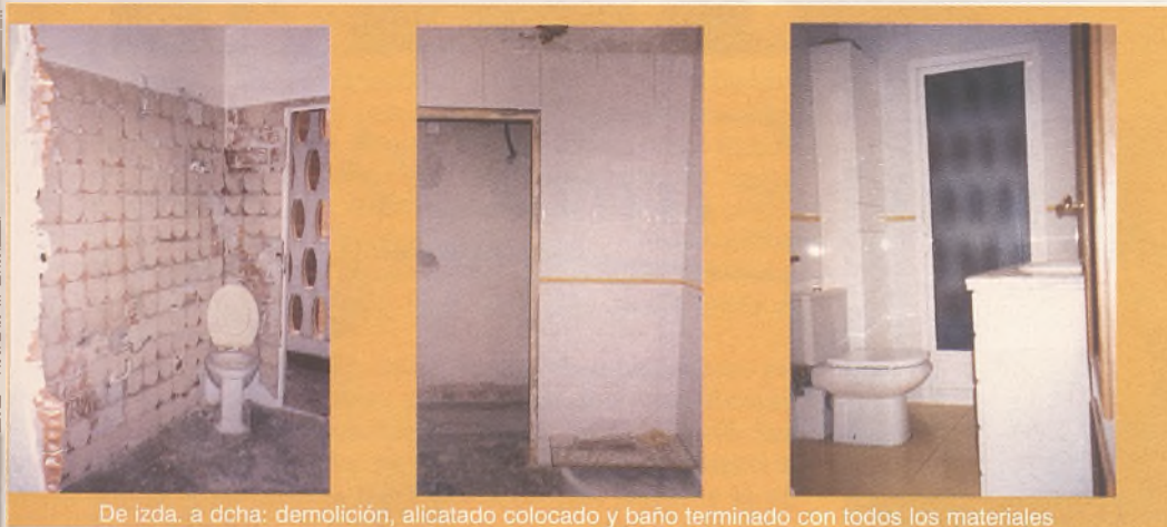
De izda. a dcha: demolición, alicatado colocado y baño terminado con todos los materiales
