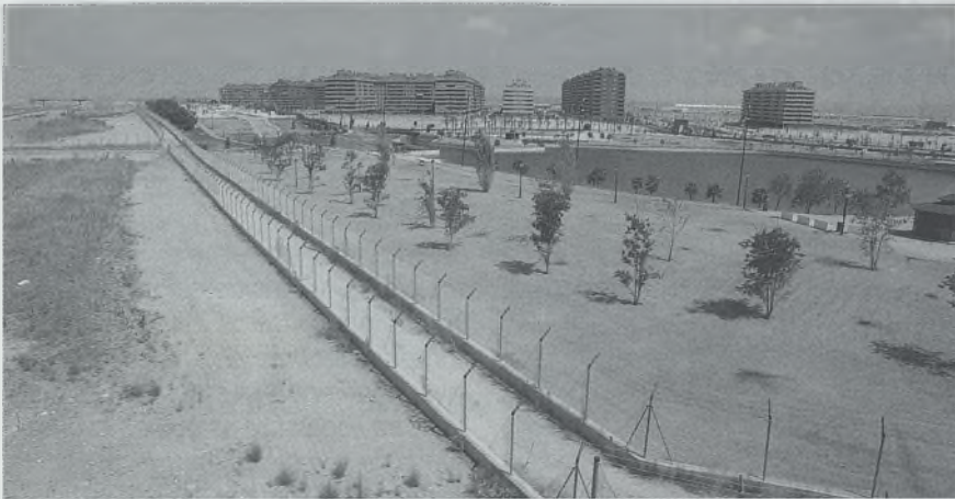
La Agrupación de Constructores calcula que en Toledo hay unas 20.000 nuevas viviendas sin vender. En la imagen, urbanización de El Quiñón, en Seseña.
