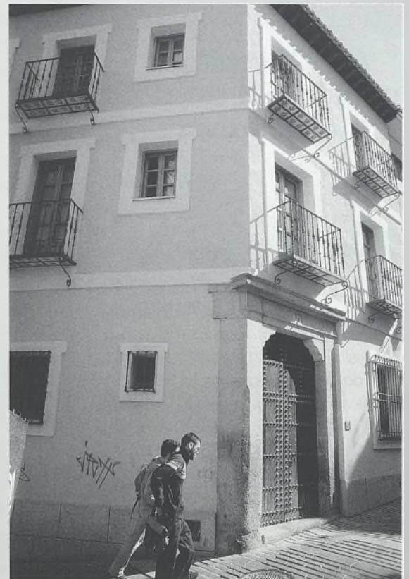
"CASA PACO". El guitarrista Paco de Lucía se gastó "un dineral" en rehabilitar su casa de Santa Leocadia. La portada del inmueble es de granito, las rejas de forja y la fachada enfoscada de cemento. Dentro tiene un estudio de grabación y un ascensor. FOTOS: SÁNCHEZ DE LA MORENA
