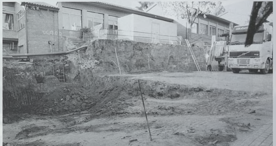
Tras varios meses de paralización de las obras, éstas se reiniciaron la semana pasada
