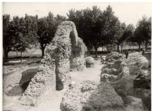
7. "Arco de entrada al 'praecintio' y apoyos de las bóvedas y graderías". Toledo, 1928 (positivo, sobre papel, 8'9 x 11'3 cm). Colección LAR-137-B
