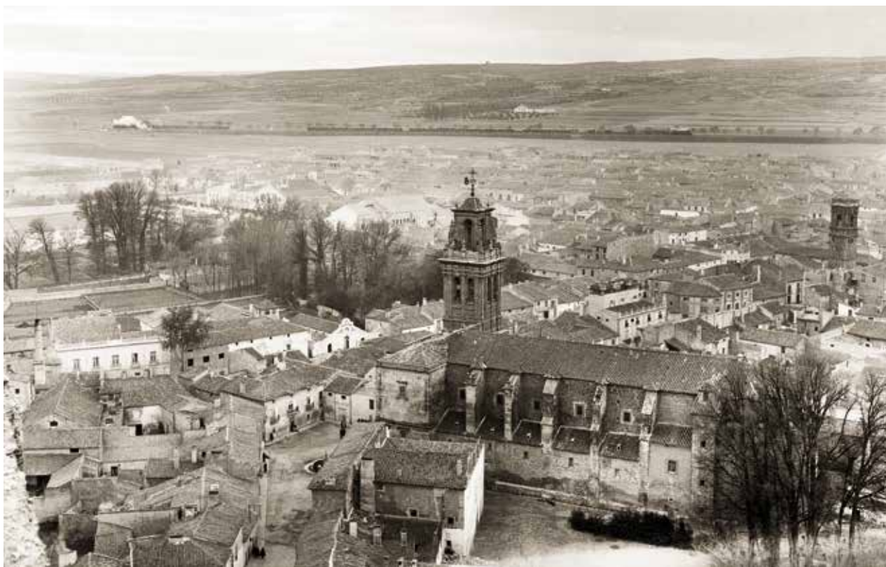
4. Iglesia de la Asunción y patio de la Casa Grande vistas desde el castillo
