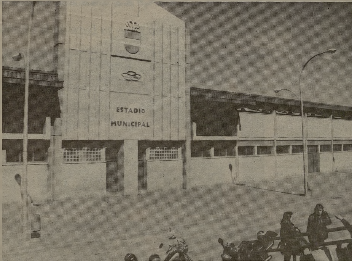
La construcción de un gran pabellón junto al estadio municipal paliará en parte el problema que genera la falta de infraestructuras deportivas.
