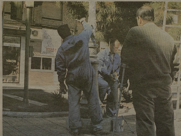
13:00 HORAS: PINTANDO LAS FAROLAS. Los trabajadores del Ayuntamiento pintan las farolas del Paseo de San Gregorio, principal arteria de la ciudad, para que Puertollano mantenga el aspecto limpio y vistoso que merece.
