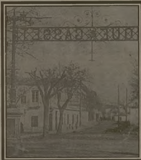
Tramo final de la calle Alarcos desde el Parque Gasset.
