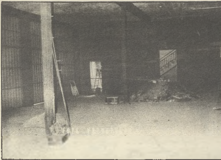
Aspecto interior del nuevo parque de bomberos
