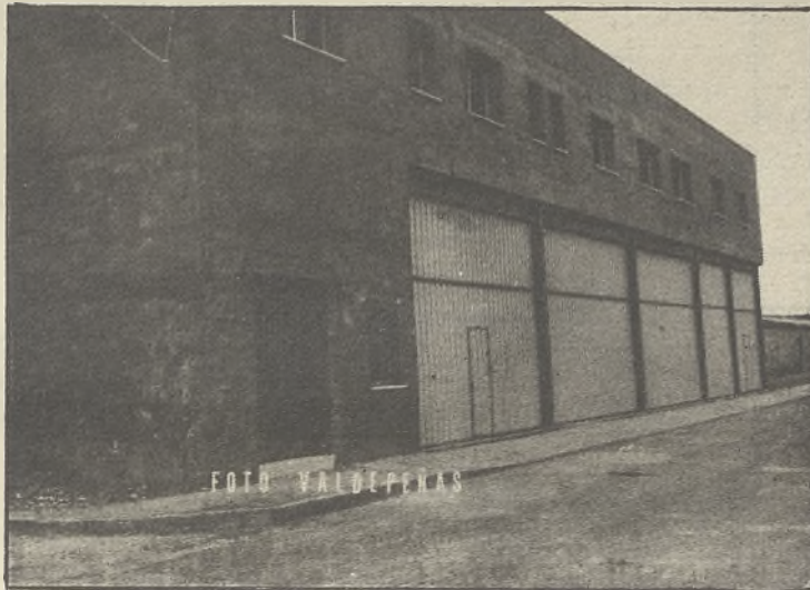
Aspecto exterior del nuevo parque de bomberos
