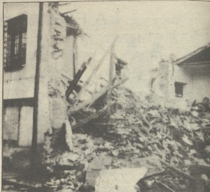
La casa derrumbada totalmente tras el segundo desprendimiento del pasado domingo
