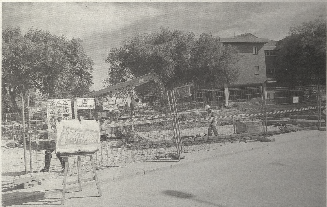
La Junta de Gobierno ha aprobado la certificación de la primera fase de las obras del comedor en el colegio Lucero
