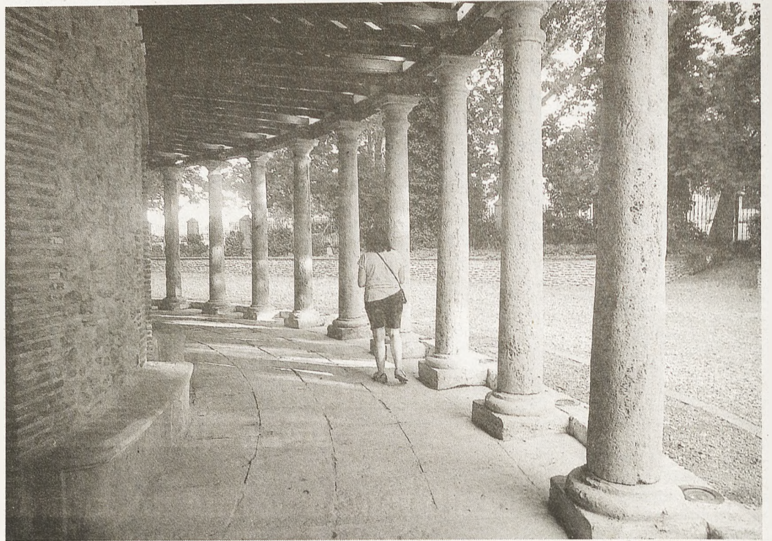
Pasillo de columnas que rodea parte del perímetro del edificio
