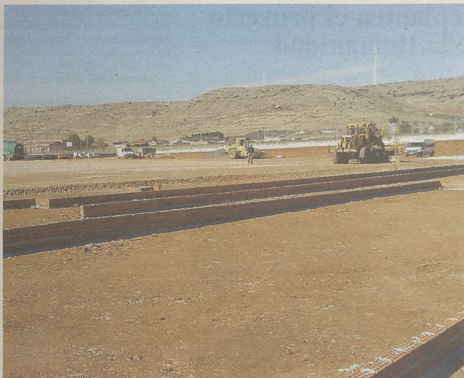
Está realizado el movimiento y tierra y la red de saneamiento
