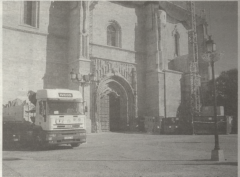
Aspecto de las obras exteriores que se están acometiendo
