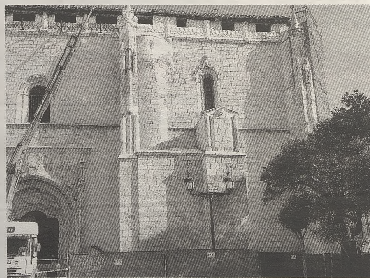
Trabajos en la cubierta del templo desde la plaza
