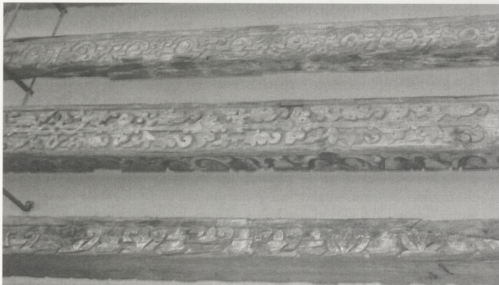
Lámina 13: Detalle de la decoración de las vigas ubicadas en el patio de la Mezquita. Foto autor.
