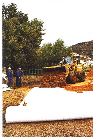
Colocación del geotextil.
