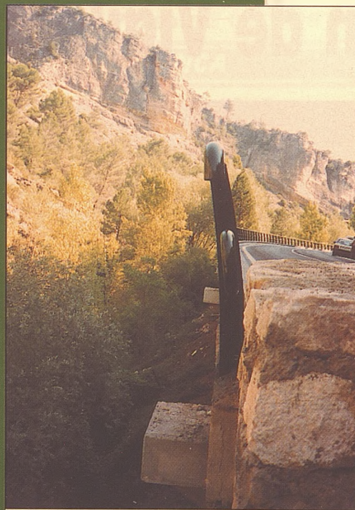
Para evitar voladuras se ha utilizado la técnica del cemento expansivo, material que se inyecta en las grietas y produce un efecto de cuña.
