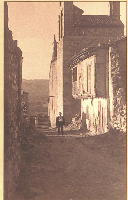
Iglesia de Santa María la Mayor y edificios anexos, en la actualidad en ruinas.
