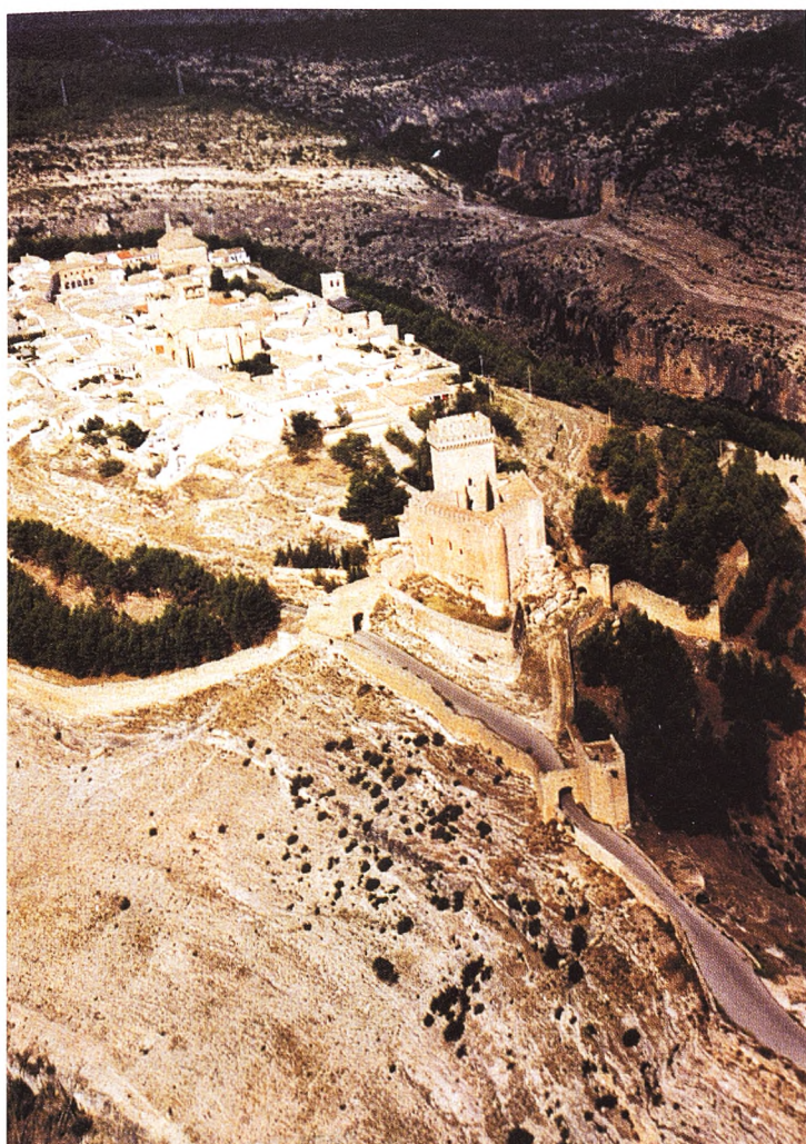
El 'Espejo de Agua' del embalse de Alarcón y la adecuación de los cauces y riberas de los ríos Júcar y Huécar a su paso por Cuenca son los proyectos más ambiciosos.
