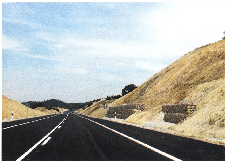
Arriba, protecciones instaladas en los quitamiedos para evitar accidentes a los motoristas. Abajo, terraplenes y desmontes necesarios para construir la carretera.
