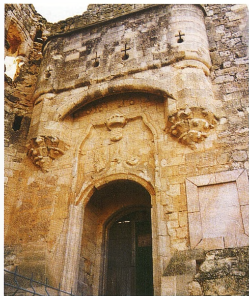
Al lado, dos imágenes del exterior del castillo de Castillo Garcimuñoz, desmochado de sus almenas, pero con las paredes exteriores mostrando la 'fuerza' de su destino. La puerta de entrada es bellísima, diseñada en estilo gótico isabelino, una joya de la arquitectura militar de la época. Debajo, castillo y pueblo visto desde los restos de la parroquia de San Juan.
