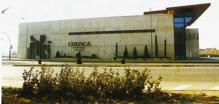
Centro de Recepción de Turistas de Cuenca. Todo hace indicar que albergará a la FAEC y a los sindicatos.
