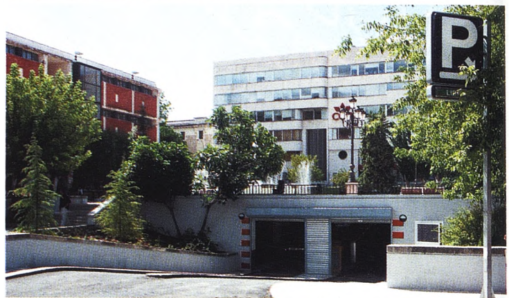
En las imágenes superiores, la renovada imagen de la Plaza de España y el acceso al remozado aparcamiento subterráneo.
