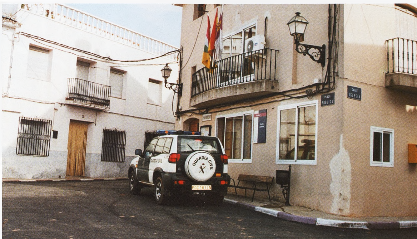
Ayuntamiento de Graja de Iniesta. Este edificio se queda pequeño por eso el alcalde ha solicitado la ayuda a las instituciones locales y regionales para construir uno nuevo.
