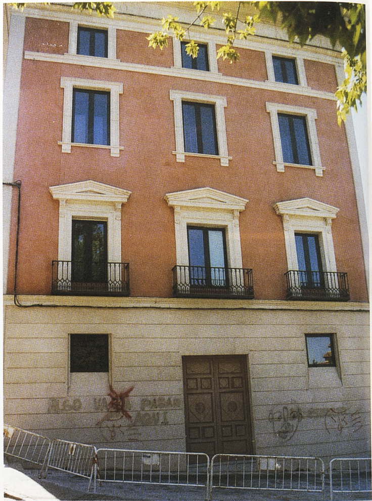
Fachada del edificio Palafox del que es propietario el Ministerio de Educación y Cultura. Las instituciones firmantes de este acuerdo esperan la cesión del mismo para comenzar las obras de remodelación de la sede de la JONDE.
