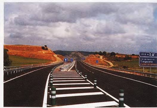
El nuevo trazado cuenta con dos kilómetros de autovía con dos carriles de circulación por sentido. Desde este punto se conectará al tramo en construcción desde Abia de la Obisपालia.
