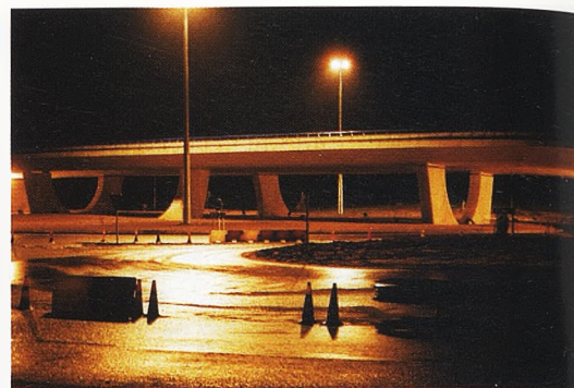
Paso elevado construido para unir la vía rápida de salida de Cuenca hacia Madrid con la Autovía de Castilla-La Mancha que ha sido denominada como A-40.
