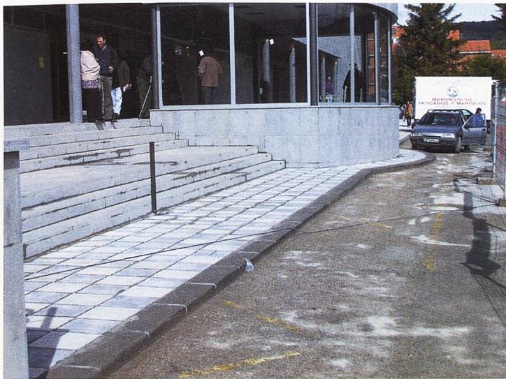
Fachada del Hospital Virgen de la Luz con su actual aspecto.
